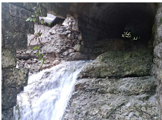
Particolare del Rio con l'affioramento roccioso e la porzione di piedritto del tombotto che ha ceduto
